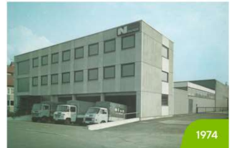
Neubau des Bürogebäudes
